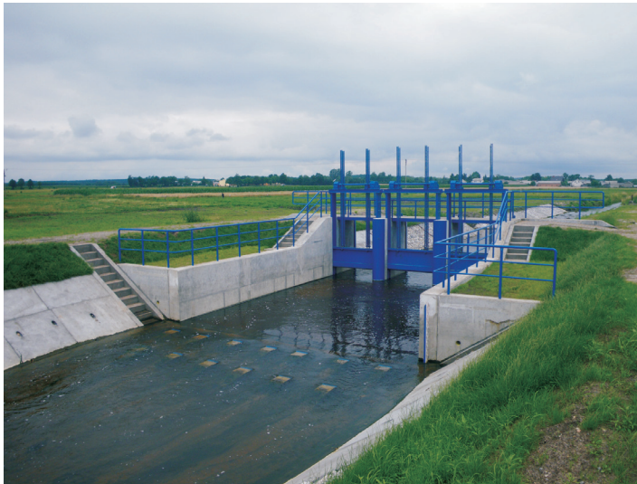
Fot. 1. Zmodernizowany jaz do nawodnień rolniczych na rzece Mławka. Przy podniesionych zasuwach nie stanowi przeszkody w migracji ryb. Poniżej widoczna niecka wypadowa oraz betonowe szyki (fot. W. Wiśniewski)
